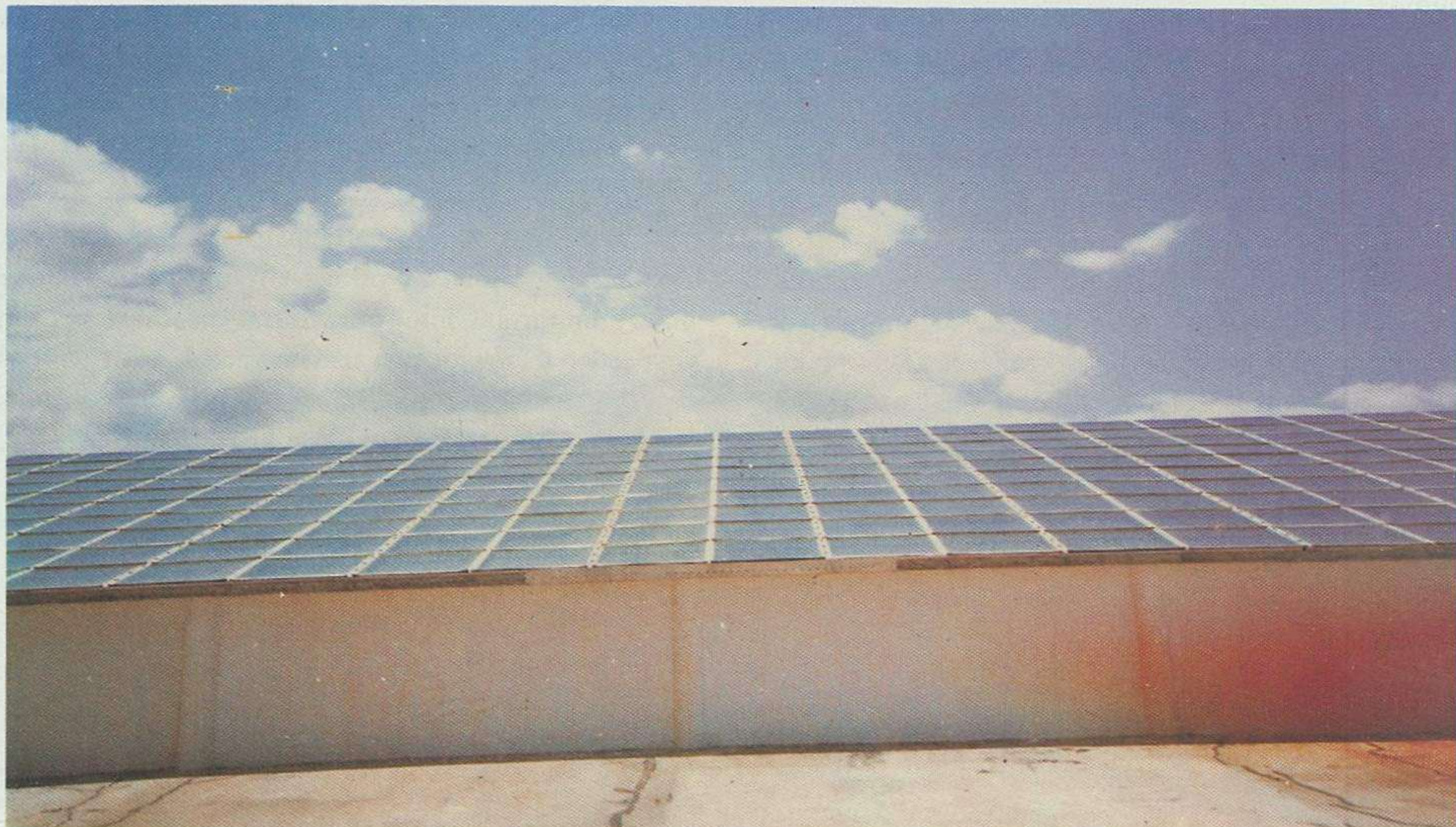
प्रसंस्कृत मिर्च, धनिया बीजों के वास्ते गर्म हवा पैदा करने के लिए सौर संग्राहक Solar Collector for hot air production of processed chillies, coriander seeds
